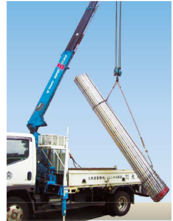
■ 使用例 (建設現場)
