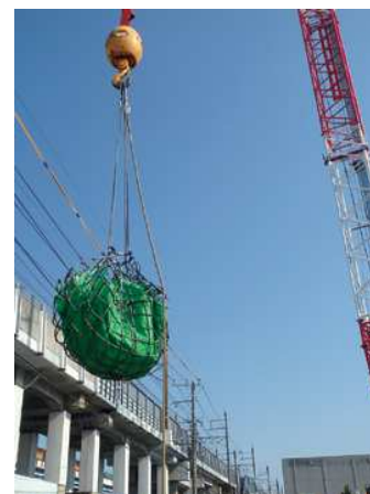
■使用例 (建設現場)
