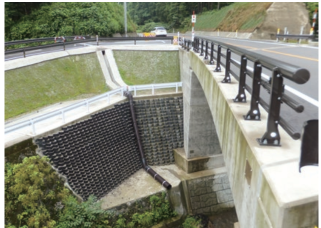
施主：石川県県央土木総合事務所 工事名：一般国道304号国道改築工事(A2橋台工) ■ 壁面勾配：1 : 0.5 ■ 壁高：7.95m ■ 壁面積：150㎡
