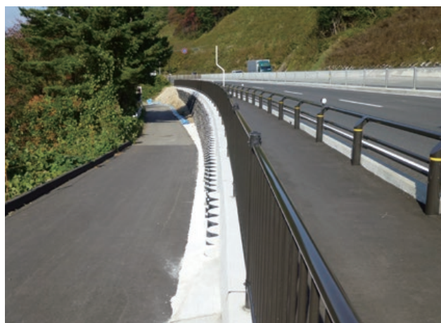
施主：北陸地方整備局新潟国道事務所 工事名：揚川改良西地区その2工事 ■ 壁面勾配：1：0.5 ■ 壁高：5.1m ■ 壁面積：150㎡
