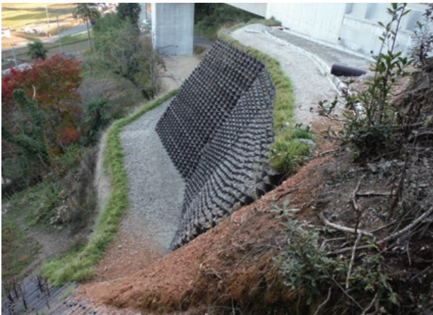
施主：近畿地方整備局福知山河川国道事務所 工事名：丹波綾部道路瀧谷工事 ■ 壁面勾配：1 : 0.5 ■ 壁高：5.1m ■ 壁面積：93㎡
