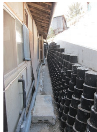
施主：山梨県峡南建設事務所 工事名：湯の岡・台地すべり対策工事 ■ 壁面勾配：1：0.2 ■ 壁高：2.25m ■ 壁面積：50㎡
