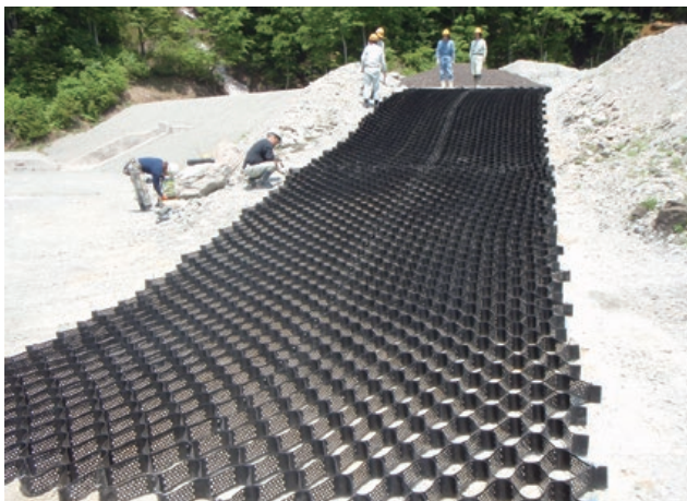
施主：北陸地方整備局長岡国道事務所 工事名：国道 289号外ノ沢流路他その2工事 概要：T-100MP、道路縦断勾配 15%
