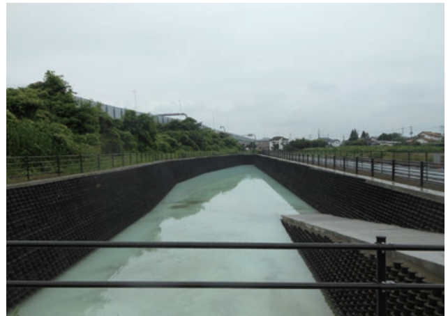
施主：東日本高速道路株式会社 工事名：首都圏中央連絡自動車道桶川北本 IC 工事 ■ 壁面勾配：1：0.4 ■ 壁高：4.35m ■ 壁面積：1,130㎡
