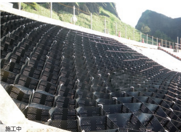
施主：新潟県新潟市西部地域土木事務所 工事名：西土第55号一般国道402号法面对策(FS18)工事 ■のり面勾配：1：1.6 ■型式：T-200LP ■のり面積：1,292㎡
