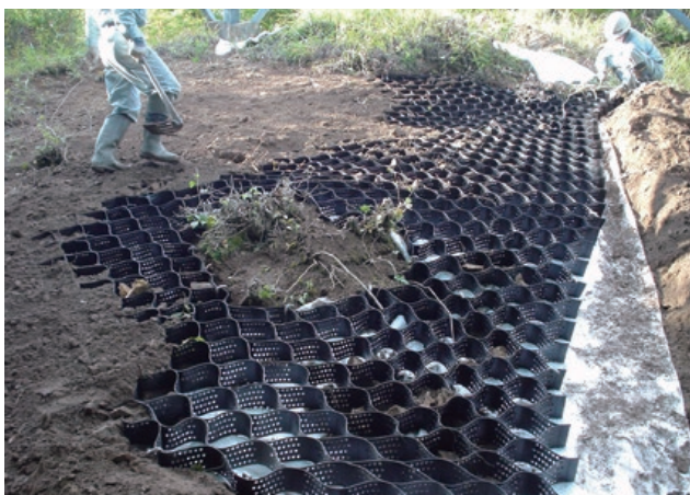
施主：中部電力株式会社（シーテック株式会社） 工事名：長野県諏訪・鉄塔株式会社のり面保護工事 ■ のり面勾配：1：1.0 ■ 型式：T-100SP ■ のり面積：87.5㎡
