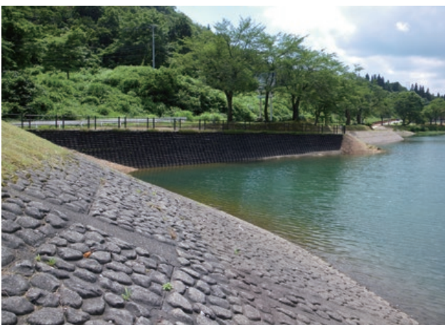
施主：新潟県魚沼市役所 工事名：鏡ヶ池周辺公園整備工事 ■ 壁面勾配：1：0.5 ■ 壁高：3.75m ■ 壁面積：260㎡
