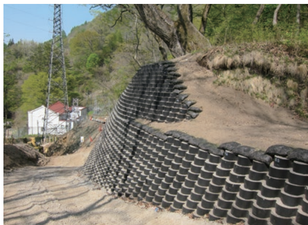
施主：東京電力株式会社 工事名：熊川第一発電所搬出入路整備工事 ■ 壁面勾配：1 : 0.5 ■ 壁高：4.95m ■ 壁面積：120㎡
