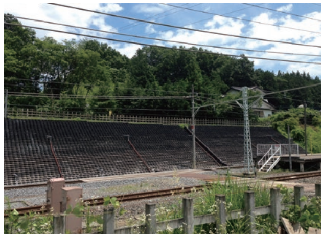
施主：東武鉄道株式会社 工事名：東武日光線災害復旧工事 F 工区 ■ 壁面勾配：1 : 1.5 ■ 壁高：6.45m ■ 壁面積：270㎡
