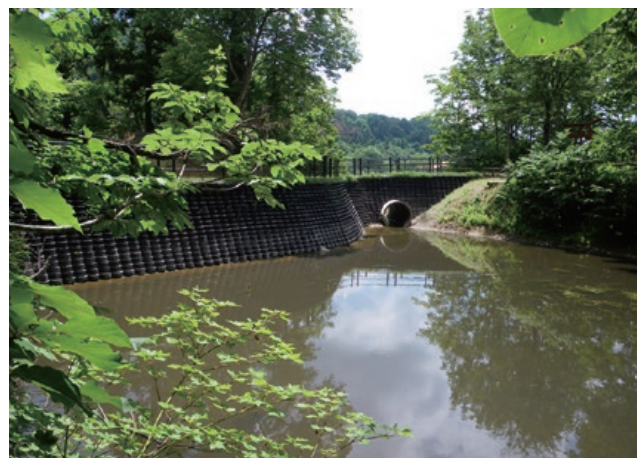
施主：中部地方整備局名四国事務所 工事名：名四国道 R23 号 BP 梅敷調整池 平成 24 年度 23 号豊橋 BP 梅敷側道建設工事 ■ 壁面勾配：1：0.5 ■ 壁高：2.4m ■ 壁面積：134㎡
