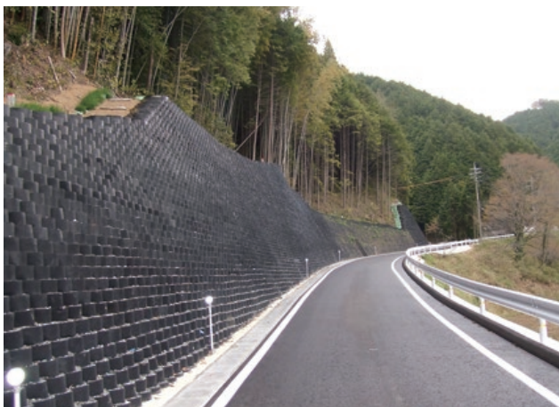
施主：岡山県備中県民局 工事名：県単道路工事(改良) 県道高梁旭線 ■ 壁面勾配：1：0.3～0.5 ■ 壁高：7.95m ■ 壁面積：560㎡
