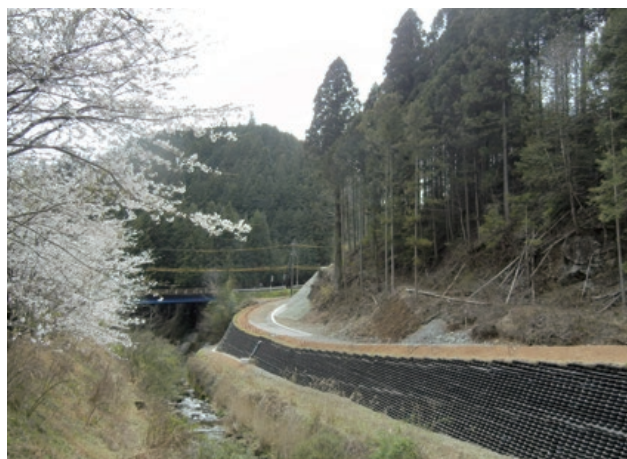
施主：愛知県新城設楽建設事務所 工事名：一般国道 R151号道路改良工事 ■ 壁面勾配：1：0.5 ■ 壁高：7.05m ■ 壁面積：602.3㎡
