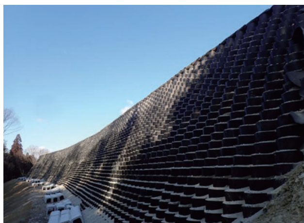
施主：民間 工事名：愛知県長久手市宅地造成工事 ■ 壁面勾配：1：0.5 ■ 壁高：6.5m ■ 壁面積：575.6㎡
