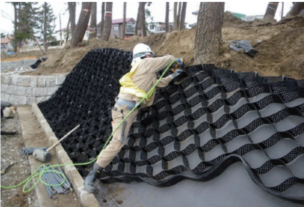
施主：新潟大学 工事名：新潟大学環境整備工事 ■ のり面勾配：1：1.0 ■ 型式：T-100MP ■ のり面積：150㎡
