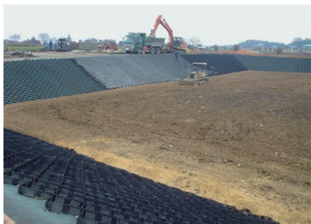
施主：栃木県真岡市役所 工事名：市道第1867号調整池築造工事 ■ のり面勾配：1：2.0 ■ 型式：T-100LP（養生シート併用） ■ のり面積：1,254㎡
