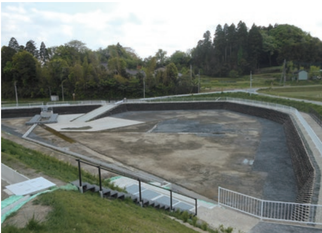
施主：東日本高速道路株式会社 工事名：首都圏中央連絡自動車道茂原南工事 ■ 壁面勾配：1：0.5 ■ 壁高：2.4m ■ 壁面積：625㎡
