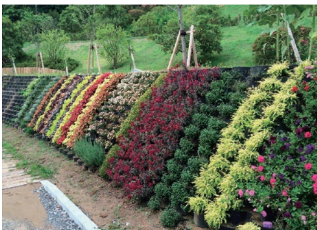
施主：三重県民間 工事名：赤塚植物園 ■ 壁面勾配：1：0.6 ■ 壁高：2.4m ■ 壁面積：144㎡
