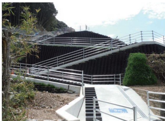
施主：高知県土佐市役所 工事名：平成27年度第1-1橋田裏山1(その1)津波指定緊急避難場所整備工事 ■ 壁面勾配：1：0.5 ■ 壁高：4.5m ■ 壁面積：318㎡
