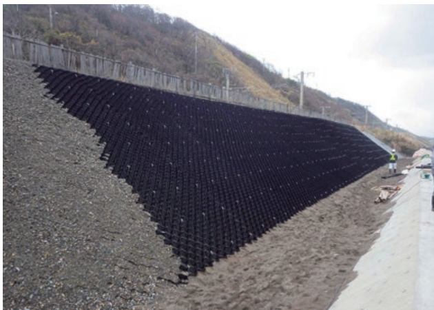
施主：JR東日本 工事名：信越本線柿崎・米山間法面侵食対策工事 ■ のり面勾配：1：1.2～1.5 ■ 型式：T-100SP ■ のり面積：860㎡
