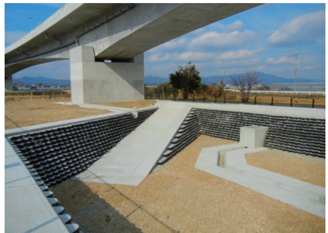
施主：中部地方整備局名四国事務所 工事名：名四国道 R23 号 BP 梅敷調整池 平成 24 年度 23 号豊橋 BP 梅敷側道建設工事 ■ 壁面勾配：1：0.5 ■ 壁高：2.4m ■ 壁面積：134㎡
