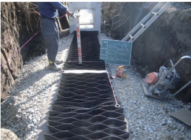
施主：民間 工事名：セイコーマート江別工業団地店新設工事 ■ 概要：T-100S×1段
