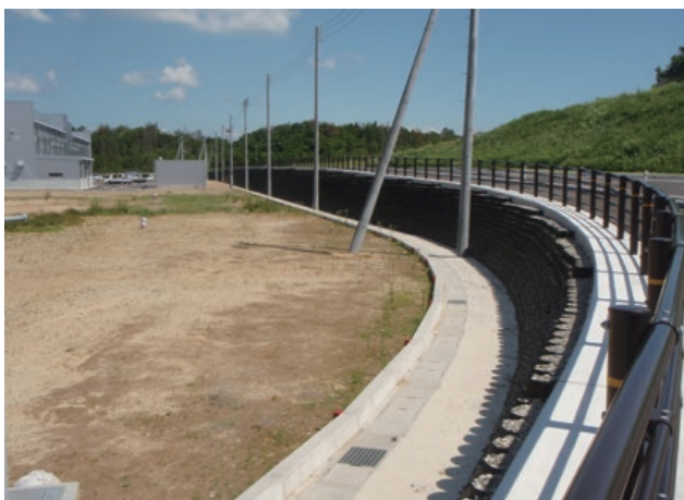
施主：新潟県長岡市役所 工事名：西部丘陵東地区産業ゾーン整備工事 ■ 壁面勾配：1：0.5 ■ 壁高：3.9m ■ 壁面積：1,120㎡
