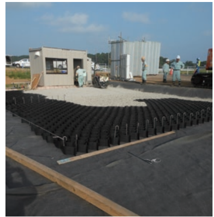
施主：東京電力株式会社 工事名：鹿島線 No.153～No.173 鉄塔立替 工事ならびに関連除去工事(1工区) ■ 概要：T-150MP×3段
