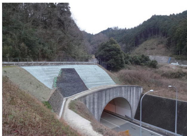
施主：中日本高速道路株式会社 工事名：伊勢道下り線松坂トンネルのり面補修工事 ■ 壁面勾配：1：1.0 ■ 壁高：4.2m ■ 壁面積：52㎡
