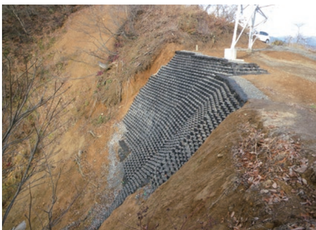
施主：東京電力株式会社 工事名：中東京幹線山線 # 100 ■ 壁面勾配：1 : 0.8 ■ 壁高：3.45m ■ 壁面積：62.4㎡
