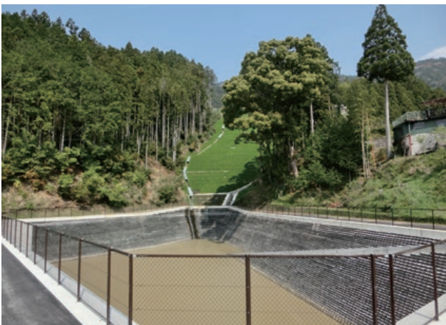
施主：中日本高速道路株式会社 工事名：第2東名道設楽原 PA 半場調整池 ■ 壁面勾配：1：0.5 ■ 壁高：7.95m ■ 壁面積：2,592㎡
