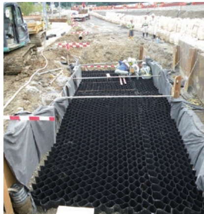
施主：上越地域振興局 工事名：柿崎牧線横住拡幅道路改良工事 ■ 概要：T-200SP×2段／T-200MP×2段
