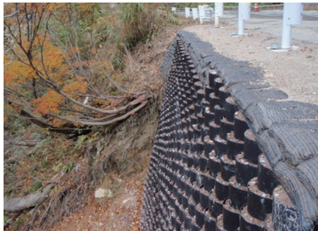
施主：新潟県魚沼市役所 工事名：市道大白川 243 号線
