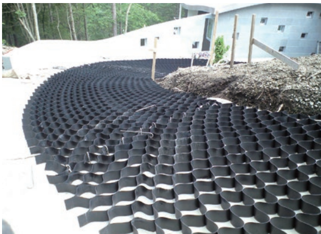
施主：民間 工事名：軽井沢別荘進入路碎石舗装補強用 概要：T-100S、道路縦断勾配 13%
