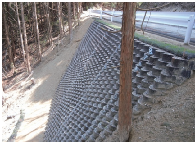
施主：愛知県豊田市役所 工事名：豊田市道羽布町二ヶ瀬地内災害復旧工事
