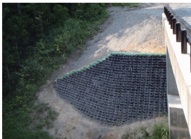
施主：北陸地方整備局新潟国道事務所 工事名：揚川改良西地区その2工事 ■ 壁面勾配：1：0.5 ■ 壁高：5.1m ■ 壁面積：150㎡
