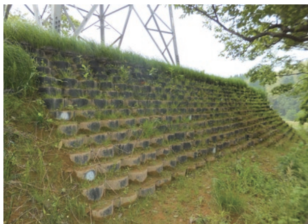
施主：北陸電力株式会社 工事名：高松線 No.29 敷地保全工事 ■ 壁面勾配：1 : 1.0 ■ 壁高：3.45m ■ 壁面積：45㎡
