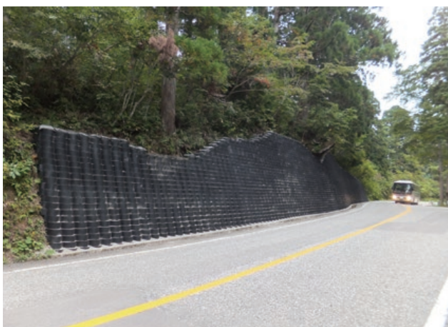
施主：富山県富山土木センター立山土木事務所 工事名：主要地方道富山立山公園線道路総合交付金(防災・防災) 法留工(下ノ小平)工事 ■ 壁面勾配：1：0.5 ■ 壁高：4.95m ■ 壁面積：221.1㎡
