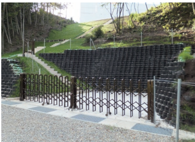
施主：北陸電力株式会社 工事名：能美送電所駐車場造成工事 ■ 壁面勾配：1 : 0.5 ■ 壁高：36m ■ 壁面積：50㎡
