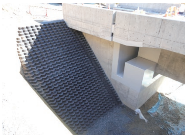
施主：東日本高速道路株式会社 工事名：首都圏中央連絡自動車道新治工事 ■ 壁面勾配：1：1.0 ■ 壁高：5.1m ■ 壁面積：34.2㎡
