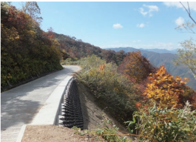
施主：富山県富山市八尾総合行政センター 工事名：白木峰市有施設管理道整備工事
