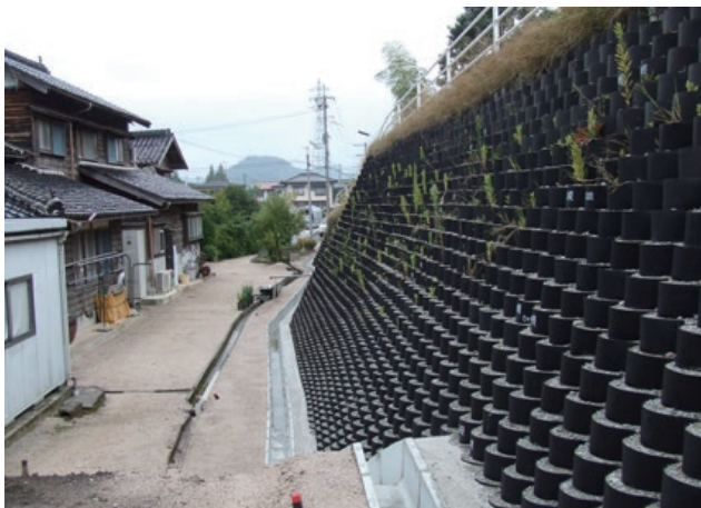
施主：鳥取県米子市役所 工事名：米子市埋蔵文化財センター ■ 壁面勾配：1：0.5 ■ 壁高：4.95m ■ 壁面積：341㎡
