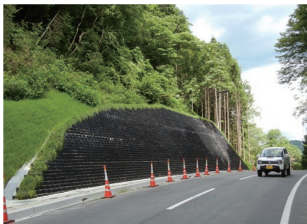
施主：愛知県豊田加茂建設事務所 工事名：一般県道平畑土岐線 ■ 壁面勾配：1：0.5 ■ 壁高：7.95m ■ 壁面積：267㎡
