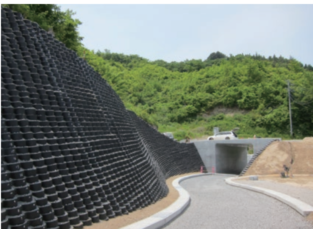
施主：岩手県宮古土木センター 工事名：市道宮古北部環状線 ■ 壁面勾配：1 : 0.5 ■ 壁高：6.75m ■ 壁面積：400㎡
