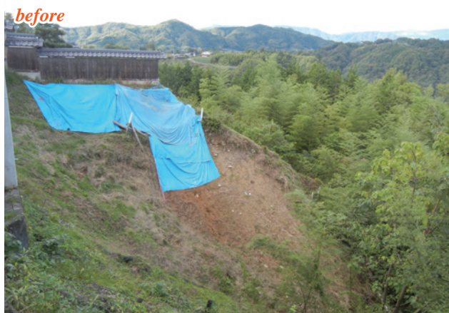
施主：長野県下条村役場 工事名：下条村コスモホール法面災害復旧工事 ■ のり面勾配：1：0.8～1.2 ■ 型式：T-100MP ■ のり面積：200㎡
