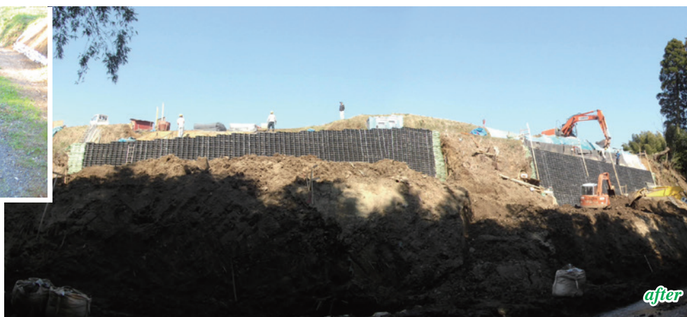
施主：千葉県勝浦市役所 / 工事名：小羽戸地区災害復旧工事 ■ 壁面勾配：1：0.3 ■ 壁高：6.75m ■ 壁面積：240㎡
