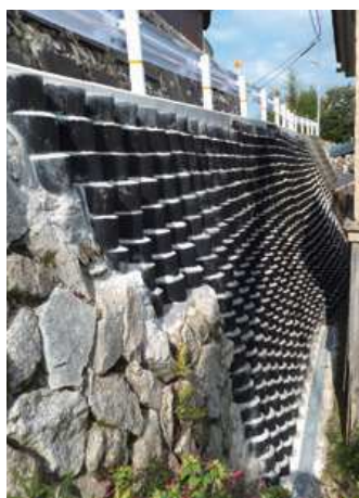
施 主：滋賀県大津市役所 工事名：市道 3313 号線 ■ 壁面勾配：1：0.2 ■ 壁高：3.0m ■ 壁面積：70㎡
