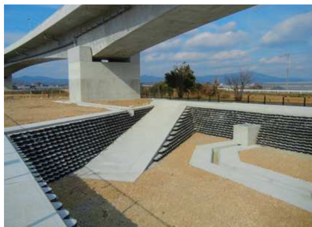
施主：中部地方整備局名四国事務所 工事名：名四国道 R23 号 BP 梅藪調整池 平成 24 年度 23 号豊橋 BP 梅藪側道建設工事 ■ 壁面勾配：1 : 0.5 ■ 壁高：2.4m ■ 壁面積：134㎡
