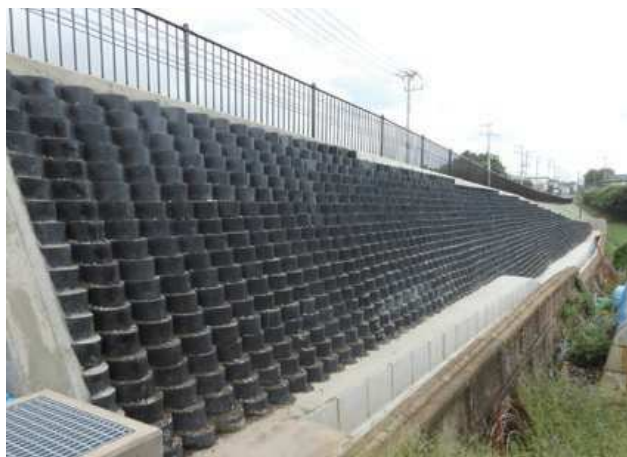
施主：茨城県水戸土木事務所 工事名：主要地方道大洗友部線 ■ 壁面勾配：1 : 0.5 ■ 壁高：3.9m ■ 壁面積：216㎡
