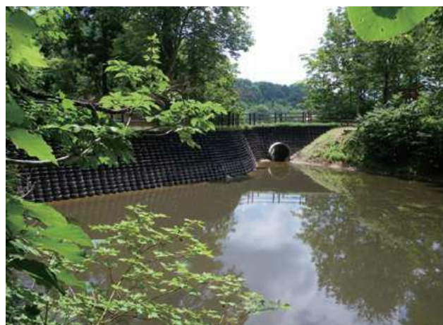
施主：中部地方整備局名四国事務所 工事名：名四国道 R23 号 BP 梅藪調整池 平成 24 年度 23 号豊橋 BP 梅藪側道建設工事 ■ 壁面勾配：1 : 0.5 ■ 壁高：2.4m ■ 壁面積：134㎡
