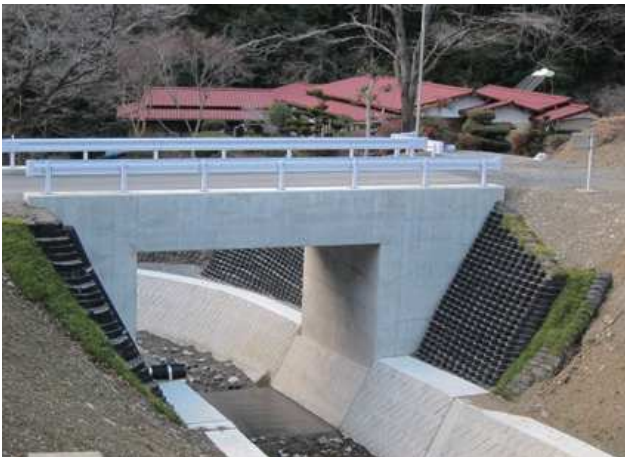
施主：山梨県峡南建設事務所 工事名：戸桶の沢砂防堰堤工事
