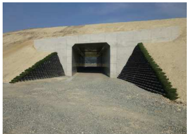
施主：東北地方整備局山形河川国道事務所 工事名：土生田道路改良工事
