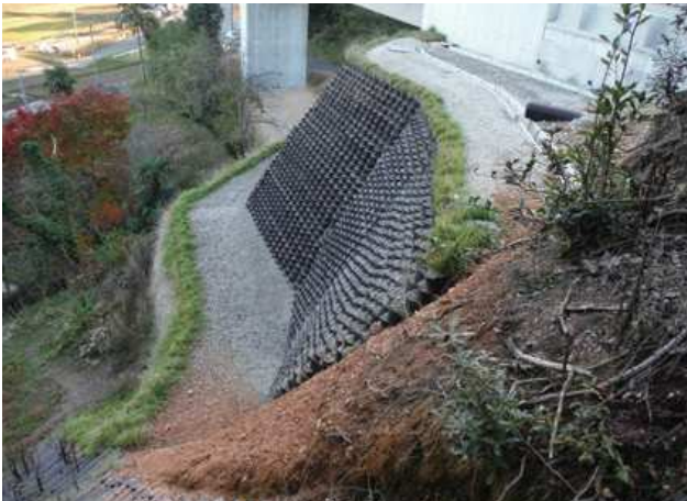
施主：近畿地方整備局福知山河川国道事務所 工事名：丹波綾部道路瀧谷工事
