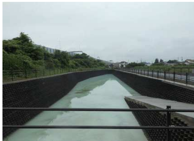
施主：東日本高速道路株式会社 工事名：首都圏中央連絡自動車道桶川北本 IC 工事 ■ 壁面勾配：1 : 0.4 ■ 壁高：4.35m ■ 壁面積：1,130㎡
