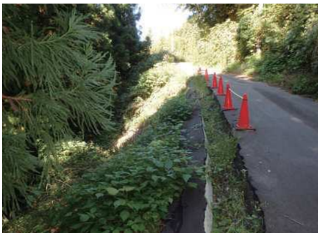
施主：新潟県十日町市役所 工事名：市道猿倉線道路災害復旧工事 ■ 壁面勾配：1 : 0.5 ■ 壁高：2.25m ■ 壁面積：40㎡
