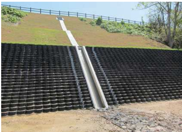
施主：青森県五所川原市役所 工事名：金木運動公園法面復旧工事 ■ 壁面勾配：1 : 1.0 ■ 壁高：5.0m ■ 壁面積：100㎡
