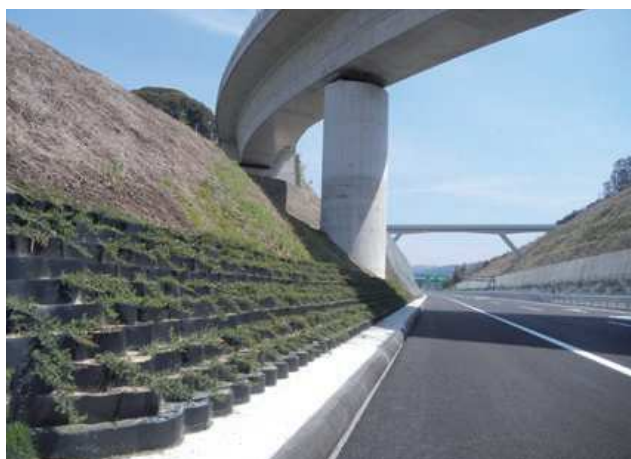
施主：中日本高速道路株式会社 工事名：新東名道いなさ JCT 造園工事 ■ 壁面勾配：1：1.0 ■ 壁高：1.5m ■ 壁面積：60㎡
