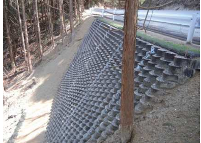
施主：愛知県豊田市役所 工事名：豊田市道羽布町二夕瀬地内災害復旧工事
