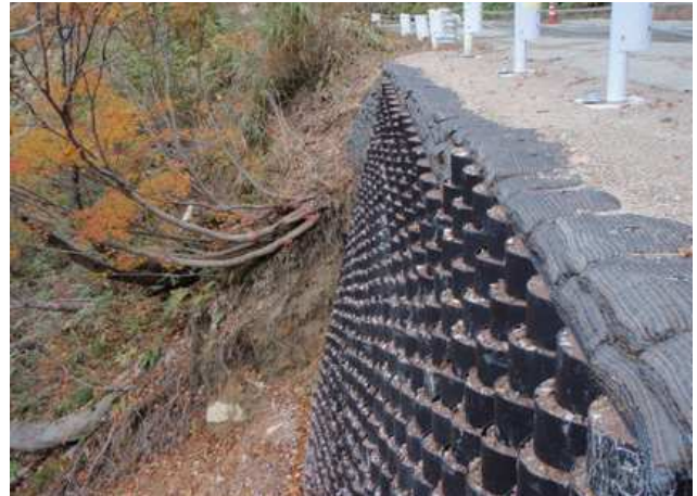
施主：新潟県魚沼市役所 工事名：市道大白川 243 号線
