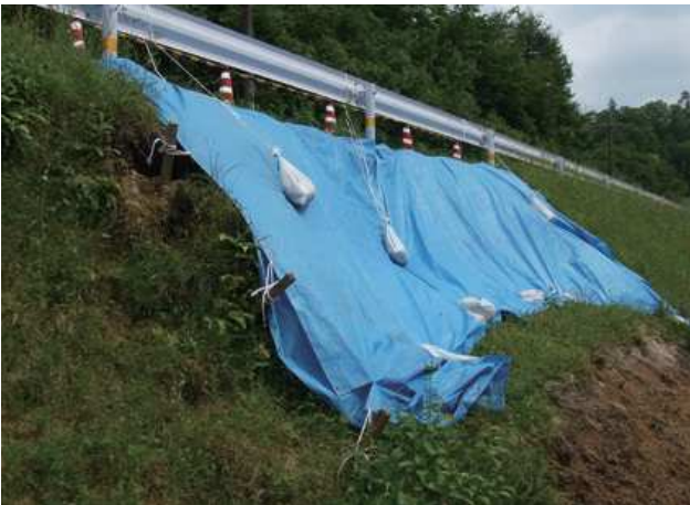
施主：島根県松江県土事務所 工事名：国道 432 号外 25 線道路維持管理
