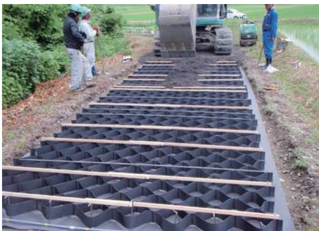
施主：新潟県南魚沼市役所 工事名：大崎地区農地・水保全管理対策交付金農道整備工事 ■概要：T-100MP、道路縦断勾配10%
