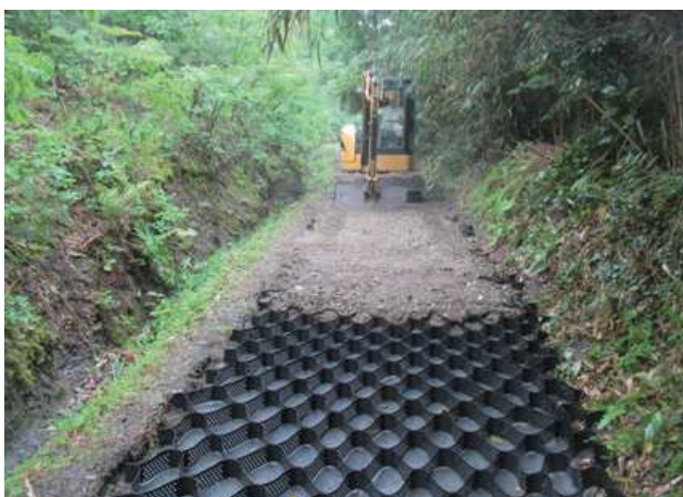
施主：新潟県佐渡市役所 工事名：市道沢根91号線路盤復旧工事 ■概要：T-100MP、道路縦断勾配10%
