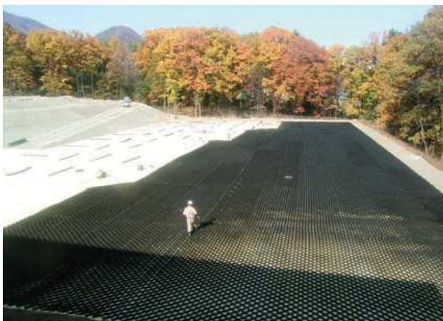
施主：民間 工事名：某民間工場臨時駐車場基礎路盤 概要：T-100M
