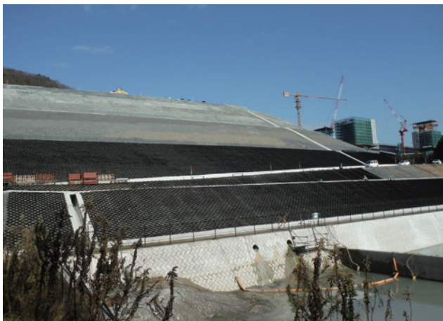
施主：西日本高速道路株式会社 工事名：新名神高速道路箕面トンネル東工事 ■ のり面勾配：1：1.8 ■ 型式：T-100LP ■ のり面積：11,800㎡
