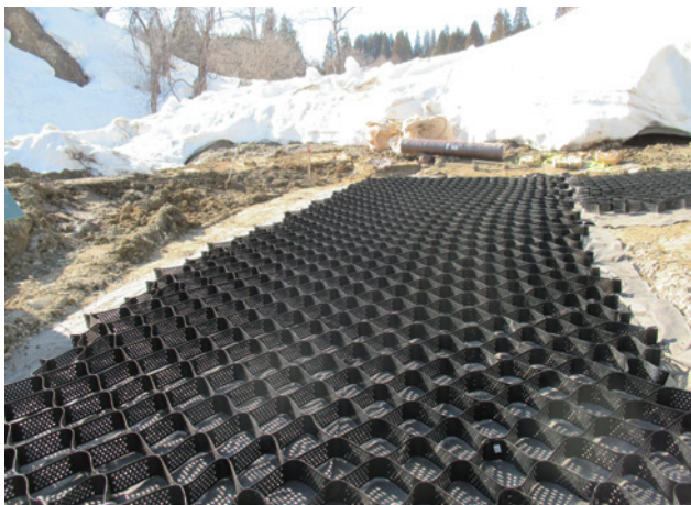
施主：新潟県南魚沼地域振興局 工事名：県営農地整備新外谷地区第 26-1 次工事 ■ 概要：T-100MP、道路縦断勾配 20%
