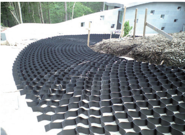
施主：民間 工事名：軽井沢別荘進入路砕石舗装補強用 概要：T-100S、道路縦断勾配 13%
