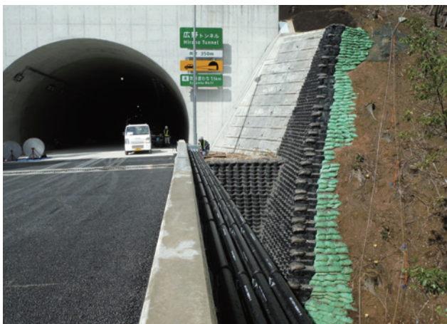
施主：近畿地方整備局福知山河川国道事務所 工事名：丹波綾部道路大簾地区舗装工事 ■ 壁面勾配：1 : 0.5 ■ 壁高：7.95m ■ 壁面積：145㎡
