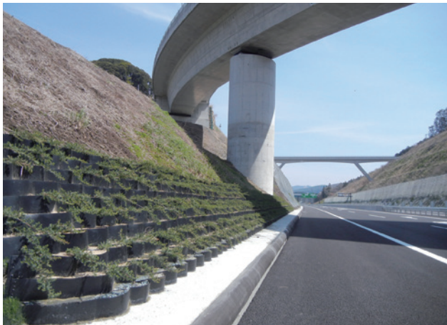
施主：中日本高速道路株式会社 工事名：新東名道いなざ JCT 造園工事 ■ 壁面勾配：1：1.0 ■ 壁高：1.5m ■ 壁面積：60㎡
