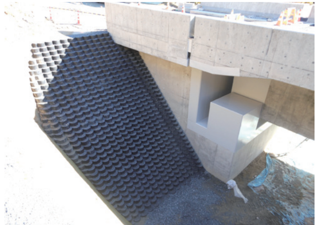
施主：東日本高速道路株式会社 工事名：首都圏中央連絡自動車道新治工事 ■ 壁面勾配：1：1.0 ■ 壁高：5.1m ■ 壁面積：34.2㎡
