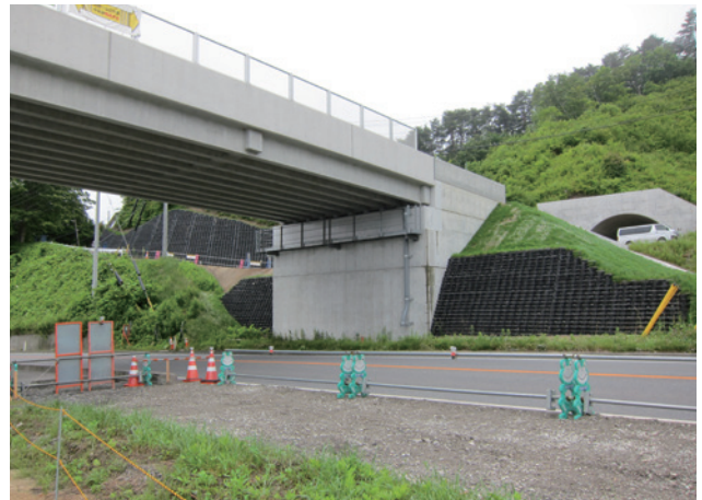
施主：岩手県宮古土木センター 工事名：市道宮古北部環状線 ■ 壁面勾配：1 : 0.5 ■ 壁高：4.5m ■ 壁面積：85㎡
