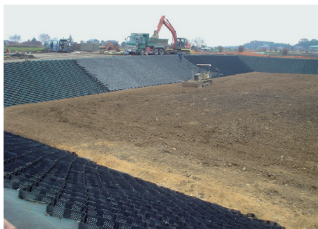
施主：栃木県真岡市役所 工事名：市道第1867号調整池築造工事 ■ のり面勾配：1：2.0 ■ 型式：T-100LP（植生シート併用） ■ のり面積：1,254㎡
