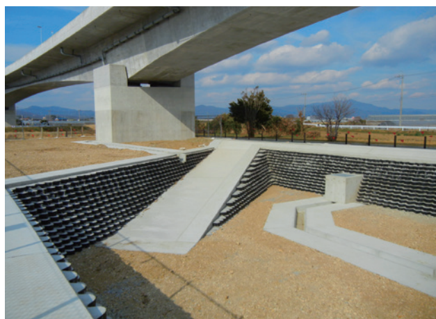
施主：中部地方整備局名四国事務所 工事名：名四国道 R23 号 BP 梅敷調整池 平成 24 年度 23 号豊橋 BP 梅敷側道建設工事 ■ 壁面勾配：1 : 0.5 ■ 壁高：2.4m ■ 壁面積：134㎡
