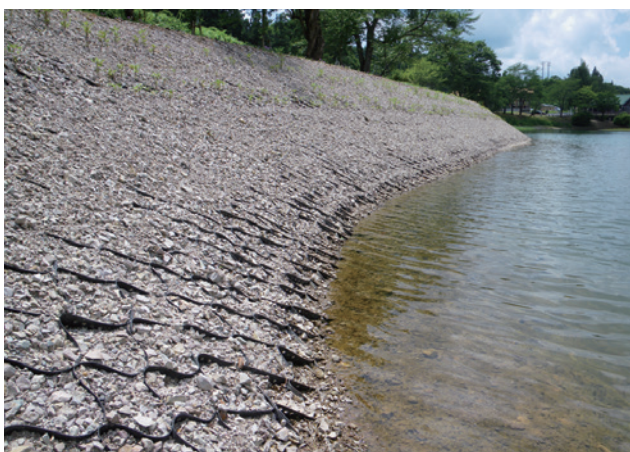
施主：新潟県魚沼市役所 工事名：鏡ヶ池周辺整備工事 ■ のり面勾配：1：1.5 ■ 型式：T-100SP ■ のり面積：550㎡
