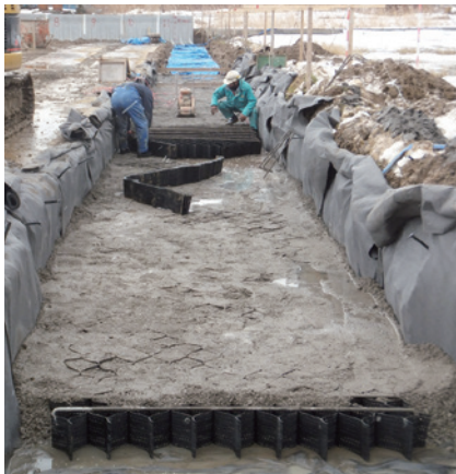
施主：福井市役所 工事名：宮ノ下公民館移転新築用地造成工事
