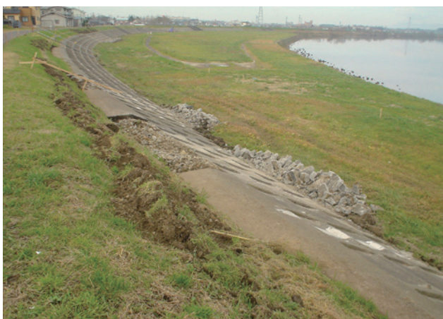
施主：能代河川国道事務所東北地方整備局 工事名：H16 中川原地区護岸補修工事 ■ のり面勾配：1：2.0 ■ 型式：T-100LP ■ のり面積：6,415㎡
