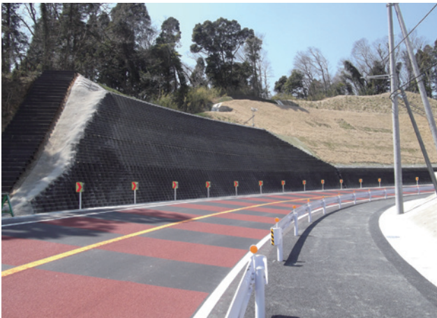
施主：東日本高速道路株式会社 工事名：首都圏中央連絡自動車道茂原北インターチェンジ工事 ■ 壁面勾配：1：0.5 ■ 壁高：6.75m ■ 壁面積：390㎡
