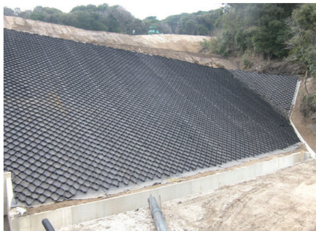
施主：九州地方整備局大隈河川国道事務所 工事名：東九州道(鹿屋～曾於)下高隈地区(第31区)改良工事 ■ のり面勾配：1：1.8 ■ 型式：T-100LP ■ のり面積：40,000㎡
