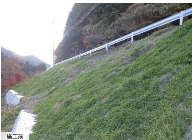
施主：茨城県常陸太田工事事務所 工事名：主要地方道北茨城・大子線道路舗装工事 ■ のり面勾配：1：1.5 ■ 型式：T-150LP ■ のり面積：270㎡
