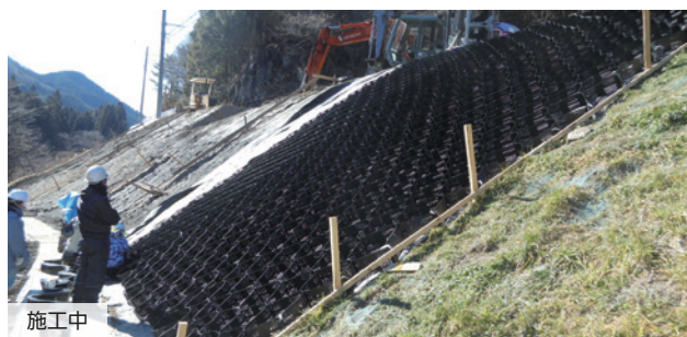
施主：九州地方整備局大隈河川国道事務所 工事名：東九州道(鹿屋～曾於)下高隈地区(第31区)改良工事 ■ のり面勾配：1：1.8 ■ 型式：T-100LP ■ のり面積：40,000㎡
