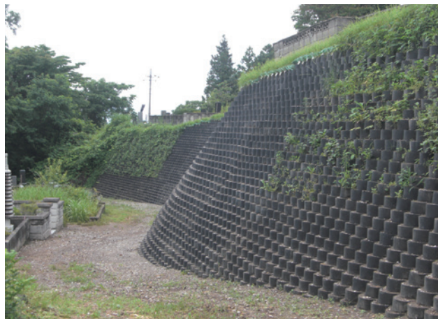
施主：群馬県渋川市役所 工事名：渋川市有墓地のり面擁壁工事 ■ 壁面勾配：1 : 0.5 ■ 壁高：5.25m ■ 壁面積：420㎡
