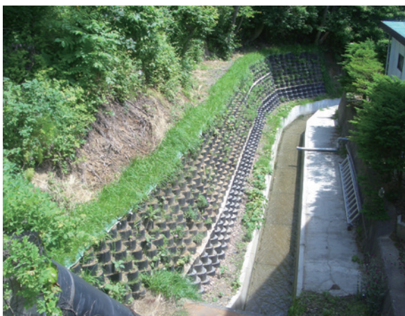
施主：長野県御代田町役場 工事名：御代田町法面侵食対策工事 ■ 壁面勾配：1 : 0.5 ■ 壁高：2.1m ■ 壁面積：50㎡
