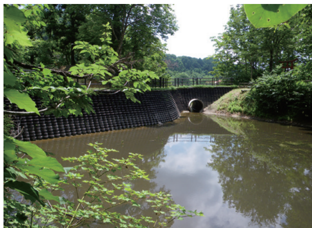
施主：中部地方整備局名四国事務所 工事名：名四国道 R23 号 BP 梅敷調整池 平成 24 年度 23 号豊橋 BP 梅敷側道建設工事 ■ 壁面勾配：1 : 0.5 ■ 壁高：2.4m ■ 壁面積：134㎡
