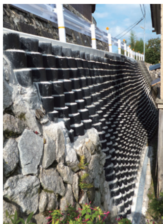
施主：滋賀県大津市役所 工事名：市道 3313 号線 ■ 壁面勾配：1 : 0.2 ■ 壁高：3.0m ■ 壁面積：70㎡
