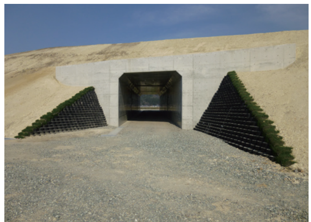
施主：東北地方整備局山形河川国道事務所 工事名：土生田道路改良工事 ■ 壁面勾配：1 : 0.5 ■ 壁高：4.35m ■ 壁面積：90㎡
