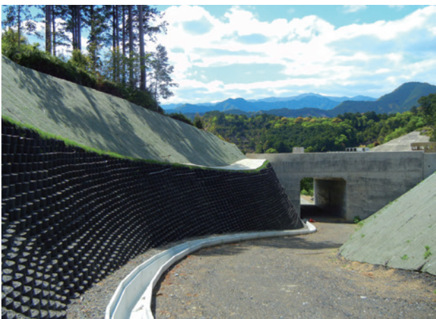
施主：中部地方整備局紀勢国道事務所 工事名：平成 23 年度紀勢線始神地区道路建設工事 ■ 壁面勾配：1：0.5 ■ 壁高：6.6m ■ 壁面積：360㎡
