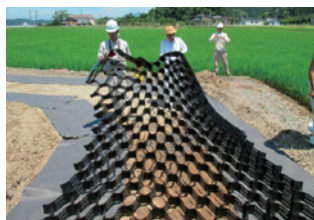
グランドセル敷設・設置 2
