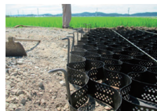
4 グランドセル敷設・設置 1
